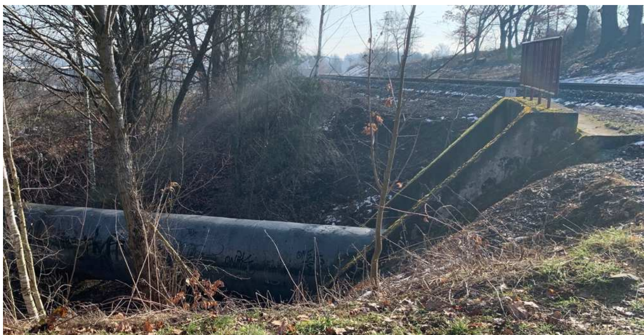
přivaděč Káraný - Praha - protlak pod tratí v km 5,609
